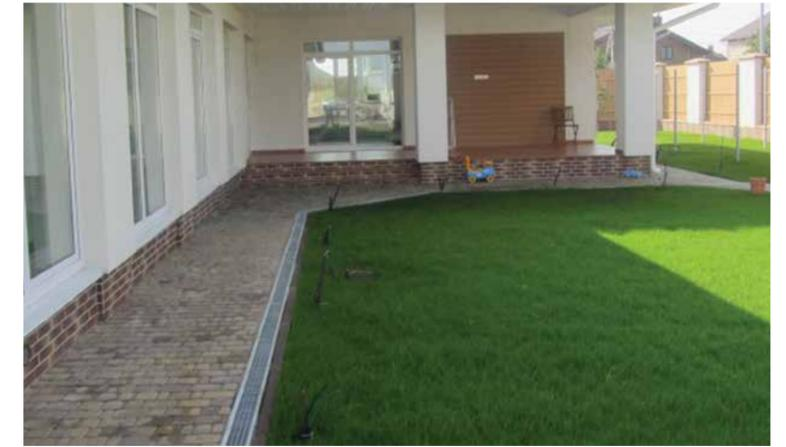
**!** Систему можно собрать без применения дождеприемника, для этого линия закрывается заглушками с двух сторон и к лотку снизу через патрубок подключается водоотводная труба.
