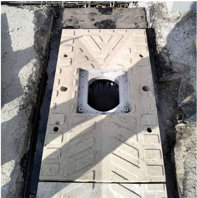
Схема монтажной сборки лотков Somromax
